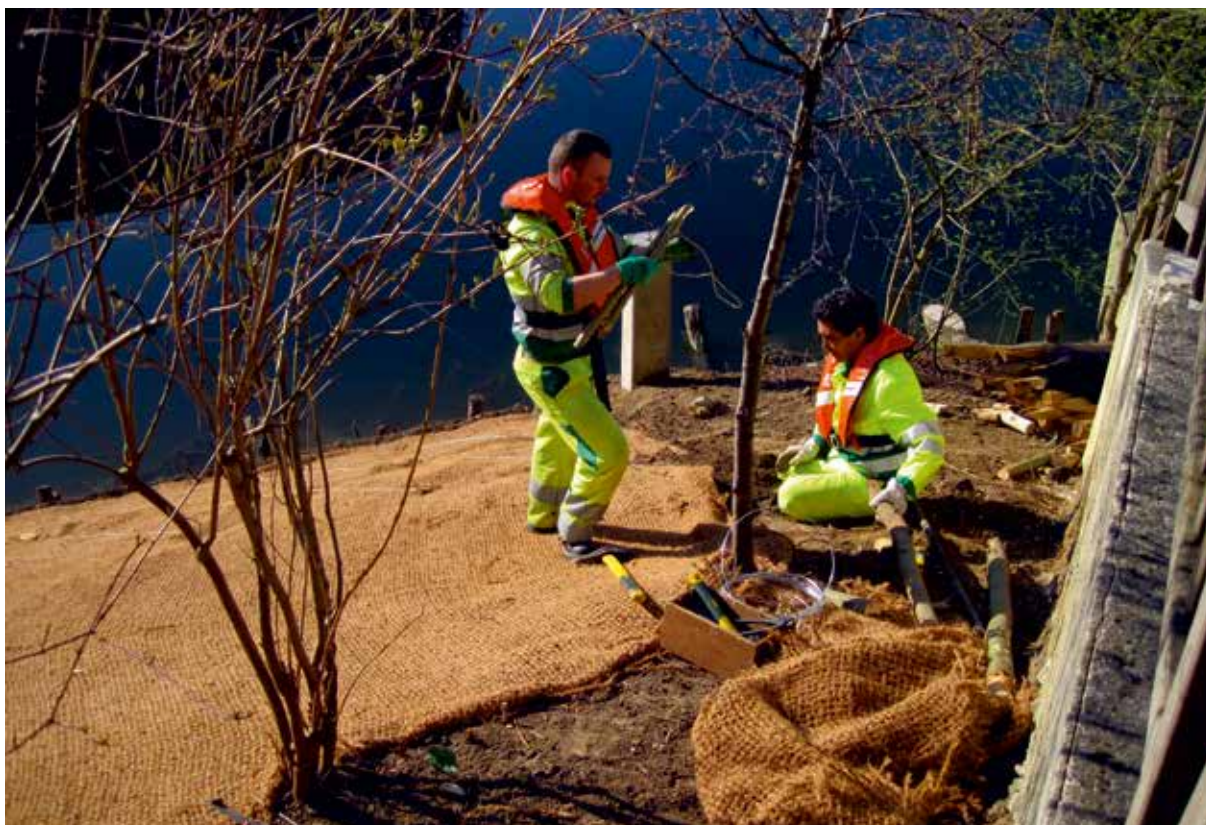
Spiling udført af Association Espaces på Île Saint-Germain ved Issy-les-Moulineaux for at stabilisere og genplante flodbredden ©Association Espaces
