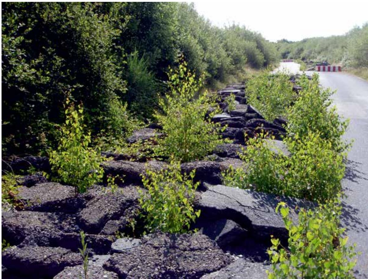
Knust asfalt giver plads til spontan vegetation på en gammel vej i Saint Jacques de la Lande ©Yann Laurent
