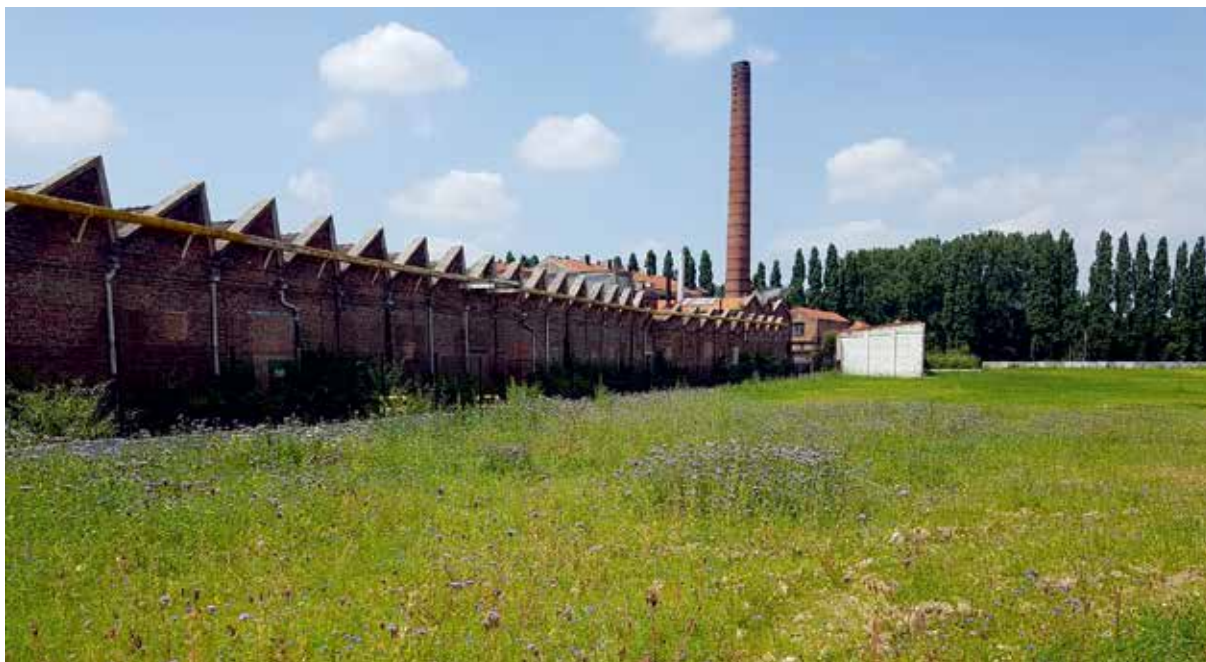
Midlertidig blomstereng på Houplines-grunden ©EPF Hauts-de-France
