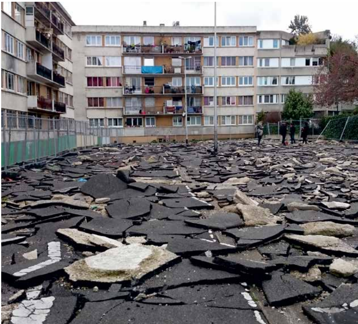
Fjernelse af befæstelse på en parkeringsplads i Aubervilliers ©Wagon Landscaping
