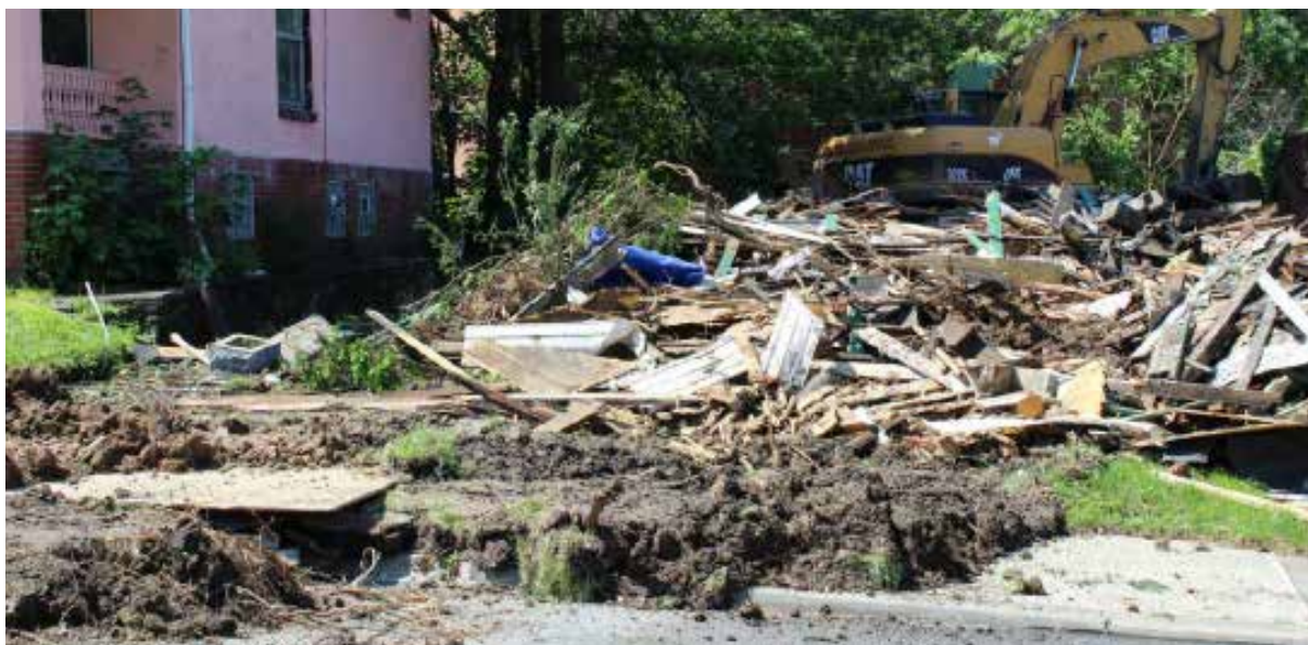
Nedrivning i Cleveland ©Turo og Gardiner, 2020 [23].
