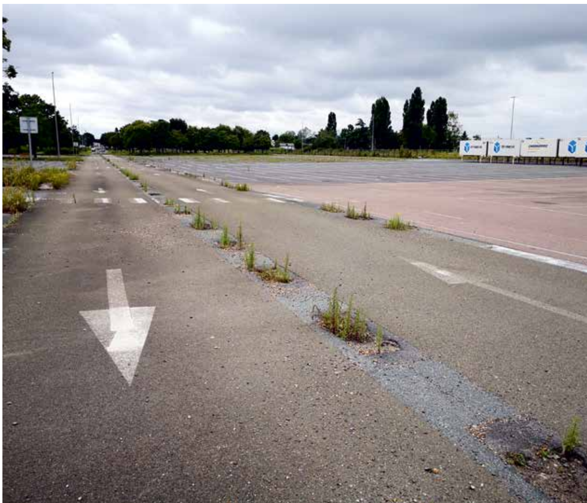
Vores byer er fulde af områder, der er blevet unødvendigt dækket af beton og asfalt, og hvor naturen kunne vende tilbage og blomstre. ©Marc Barra
